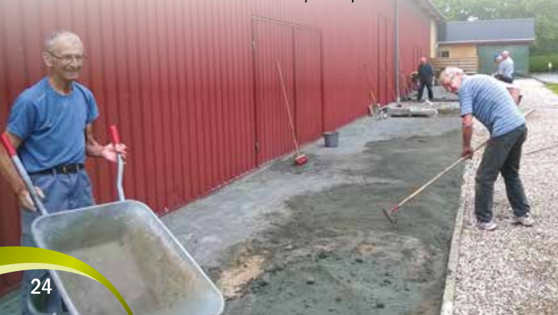
Anlæggelse af ny petanquebane 2014.
