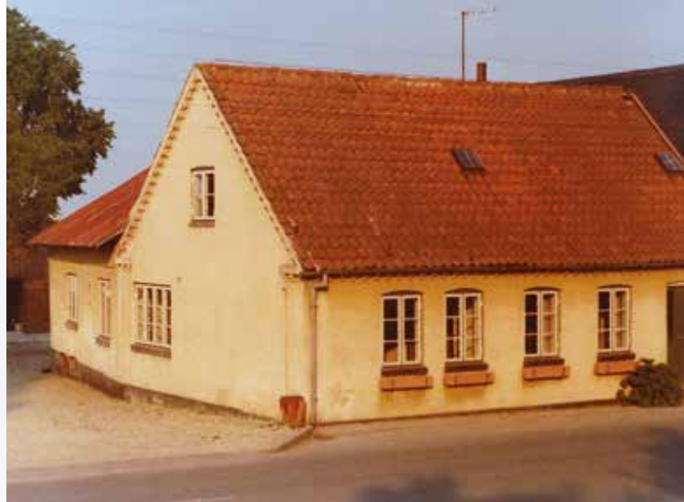
Når man ser bort fra bygningen med den høje gavl ud mod vejen, ser man den gamle "Brugs", som både var beboelse og butik.
